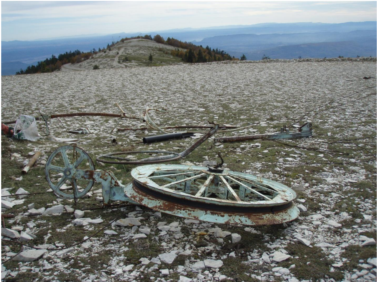
Démantèlement d'une petite station sur la montagne de Lure, Alpes-de-Haute-Provence | 2011
